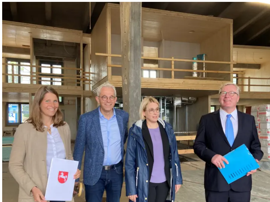
Die Künstliche Intelligenz müsse im Dienst des Menschen stehen, erklärte Wirtschaftsminister Bernd Althusmann (rechts) auf der Baustelle des Coppenrath Innovation Centre im ehemaligen Ringlokschuppen. CDC-Geschäftsführerin Sarah Wöstmann (links) nahm den Förderbescheid entgegen. Das Foto zeigt außerdem Oberbürgermeisterin Katharina Pötter und Gerd Hoofe, den Geschäftsführer der Lokviertel OS GmbH. FOTO: RAINER LAHMANN-LAMMERT
